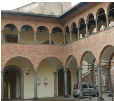
Abbildung B3.20: Rundbögen mit Stahlzugband
