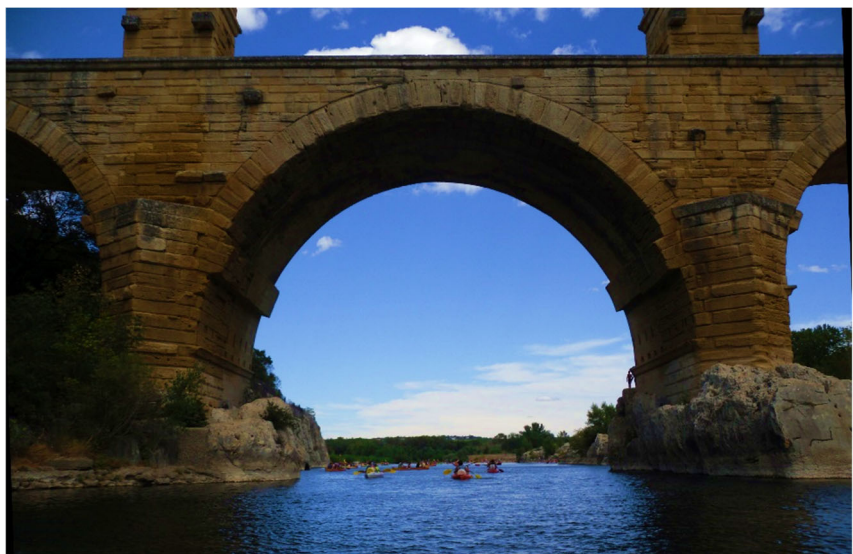
Abbildung B3.22: Bogen aus der unteren Ebene des Pont du Gard, massives Fundament und Stützpfiler
